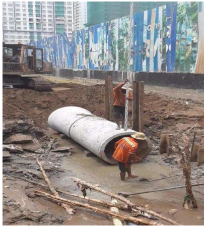
Hình 5-12 Kiểm tra cao độ đặt công D1000
