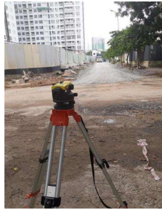
Hình 5-5 Kiểm tra cao độ bằng Máy thủy bình
