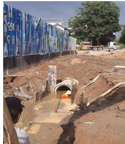
Hình 5-13 Hạ đáy hố ga đúc sẵn và đặt công lên đáy hố ga
