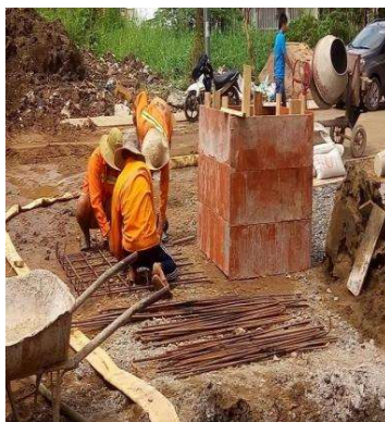
Hình 5-2 Đóng ván khuôn và đổ bê tông hố ga
