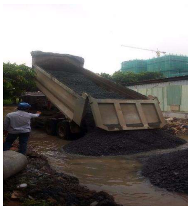
Hình 5-3 Hiện trạng nền đường và đổ đá trên đường số 08
