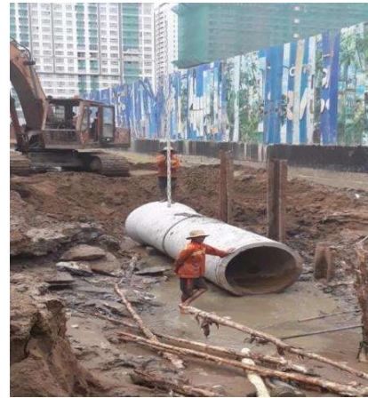
Hình 5-12 Kiểm tra cao độ đặt công D1000
