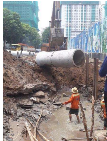
Hình 5-11 Đặt gói công và hạ công D1000
