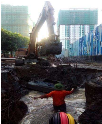
Hình 5-13 Hạ đáy hố ga đúc sẵn và đặt công lên đáy hố ga
