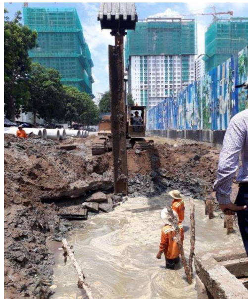
Hình 5-10 Bơm nước và gia cố thành hố đào
