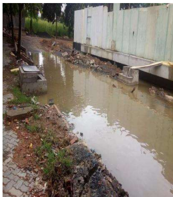
Hình 5-3 Hiện trạng nền đường và đổ đá trên đường số 08
