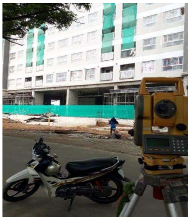
Hình 5-1 Dẫn cao độ và định vị tọa độ vỉa hè và mép đường
