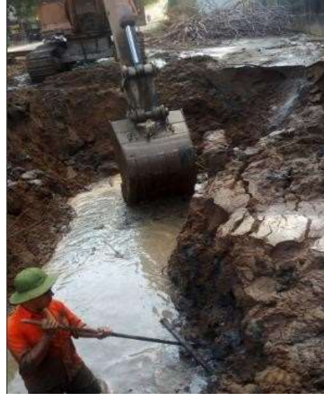
Hình 5-9 Đào cống D1000
