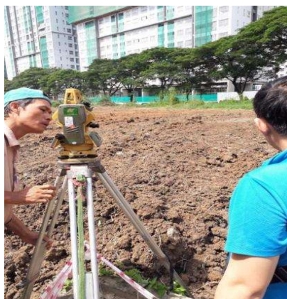
Hình 5-1 Dẫn cao độ và định vị tọa độ vỉa hè và mép đường
